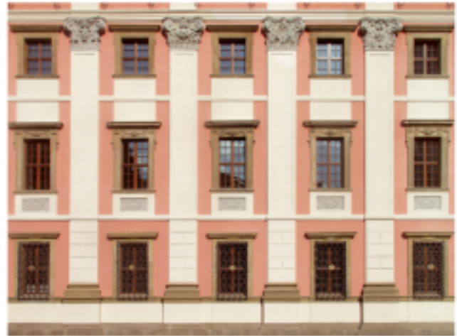
sloupy prostupující více podlaží
