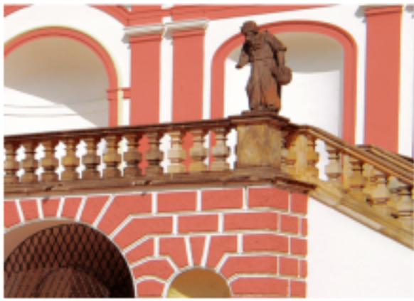
schodiště s balustrádovým zábradlím
